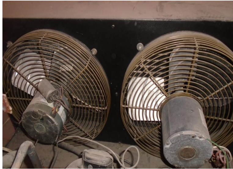
FIGURA 3. 1 Condensadores
