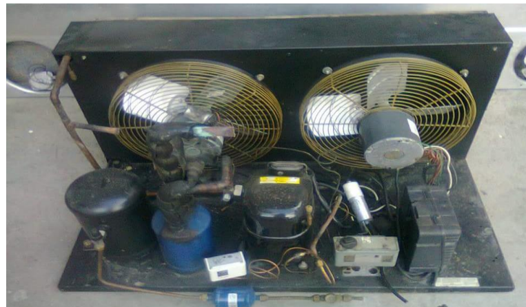
FIGURA 3. 11 Unidad condensadora
