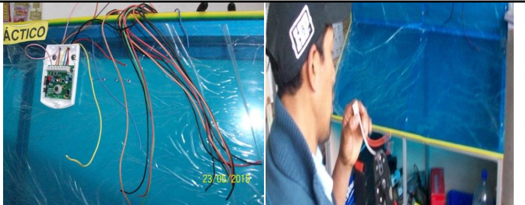
Figura 3.4. MONTAJE DEL PANEL FRONTAL Y PANEL BASE SUPERIOR DEL MÓDULO
