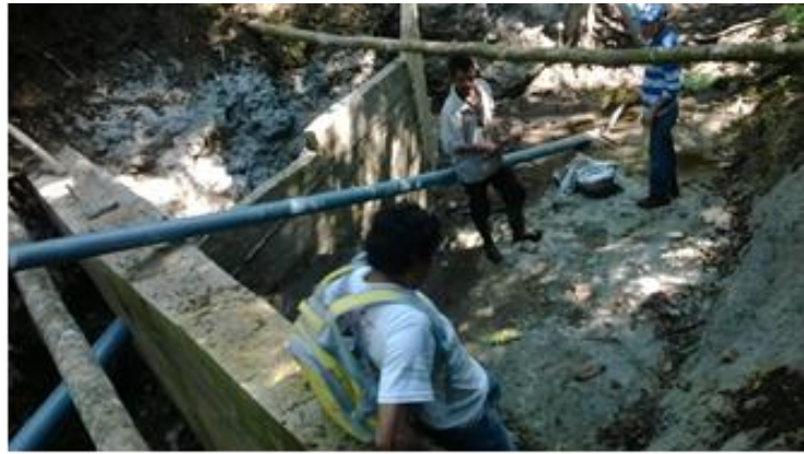
Montaje de Tubería a la Cámara de Carga.
