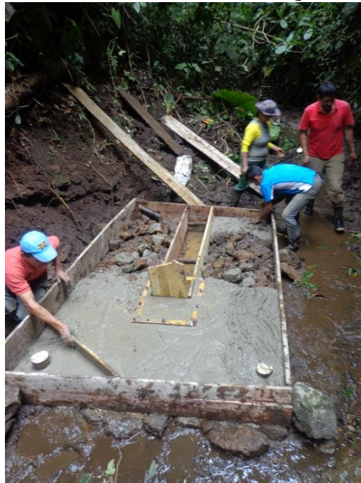
FIGURA N°3.26 “CONSTRUCCIÓN DE LA CIMENTACIÓN DE LA MÁQUINA”
