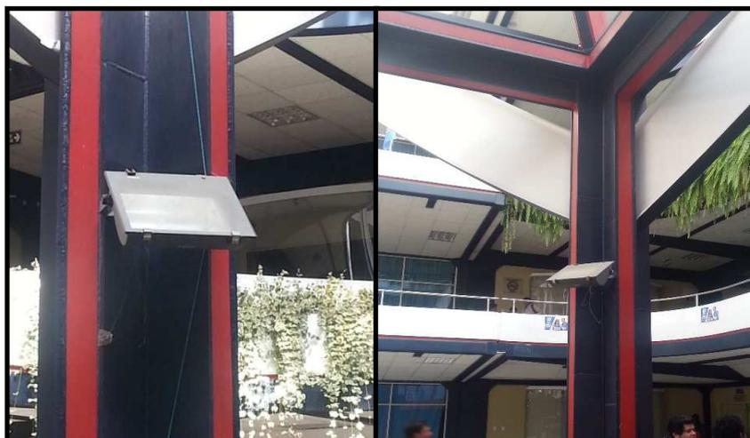
En la imagen 2.3 se muestra la estructura metálica antisísmica que se encuentra ubicada en el centro del bloque “B” cuenta actualmente con sistema de iluminación que comprende de 4 reflectores de bulbo incandescente de 150W, 220V AC que se encuentra obsoleto y con una fuente de alimentación de la red pública, esta se encuentra instalada en referida estructura.
