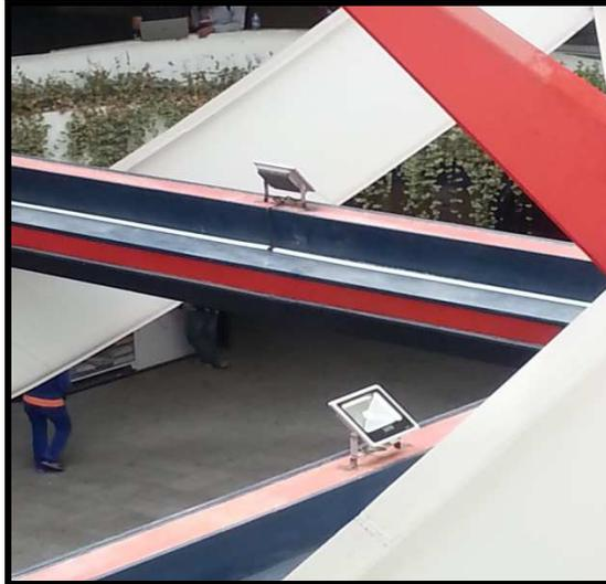
Posteriormente se efectuó la instalación de 4 reflectore LED ya existentes con cambios realizados(luz incandescente por luz led) (Imagen 3.15).
