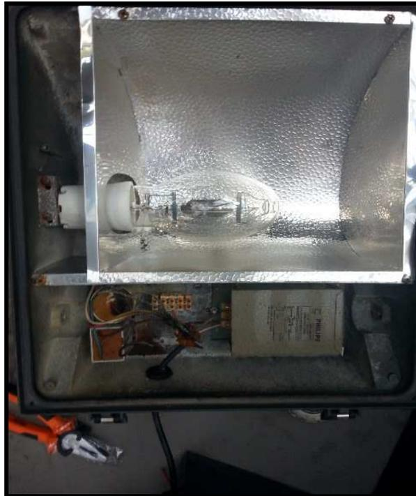
b) Desinstalación de materiales obsoletos de los reflectores existentes. Como se puede observar en la imagen 3.4, estos materiales se encontraban en pésimo estado, razón por lo cual los mismos no funcionaban adecuadamente (Imagen 3.5).
