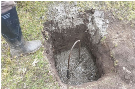
Figura 3. 45 Anclajes varilla de 8mm
