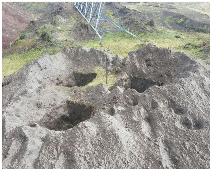
Figura 3. 47 Armado de la cimentación
