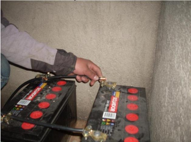
Conexión eléctrica en paralelo y conexión al inversor.
