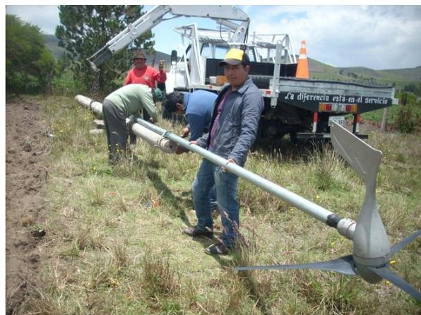
Izaje del poste con el aerogenerador ensamblado
