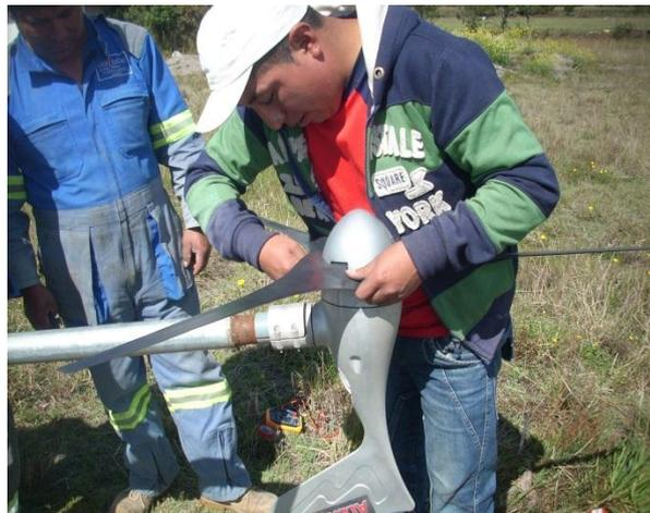
Acoplamiento del tubo en el poste de hormigón
