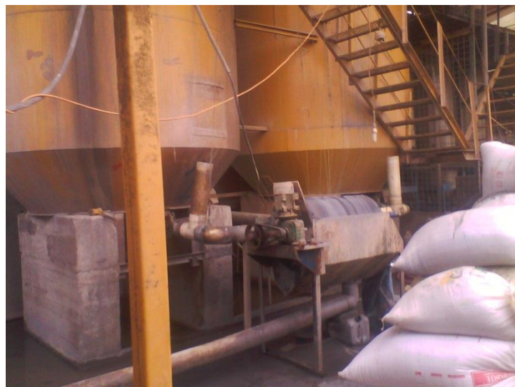
Ilustración 11: Área de Tanques de Agitación
