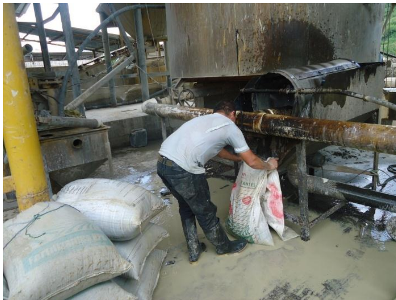
Ilustración 1: Área de Tanques
