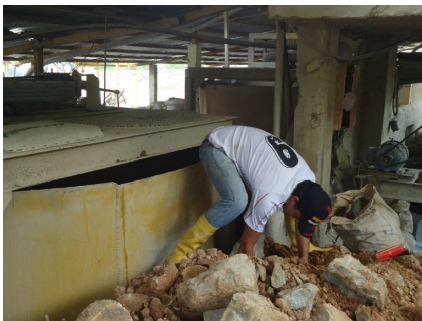
Ilustración 3: Área de Molienda y Trituración
