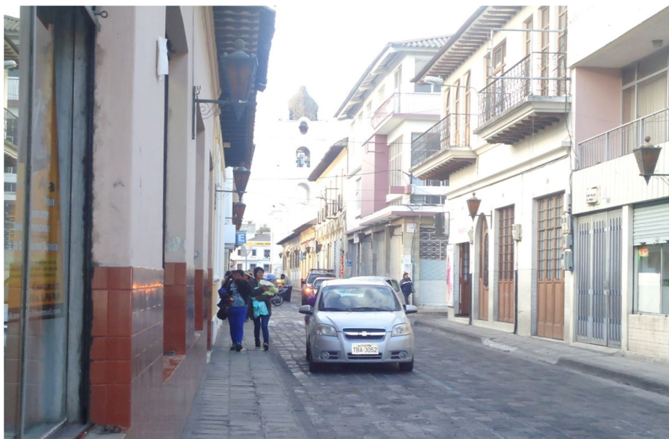
Fotografía 18. Intersección Calle Quito y Calle Tarqui
