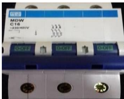
FIGURA N° 24 BREAKER TRIPOLAR 16 AMPERIOS 230/400 VAC
