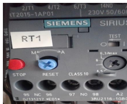
FIGURA N°15 RELÉ TÉRMICO
