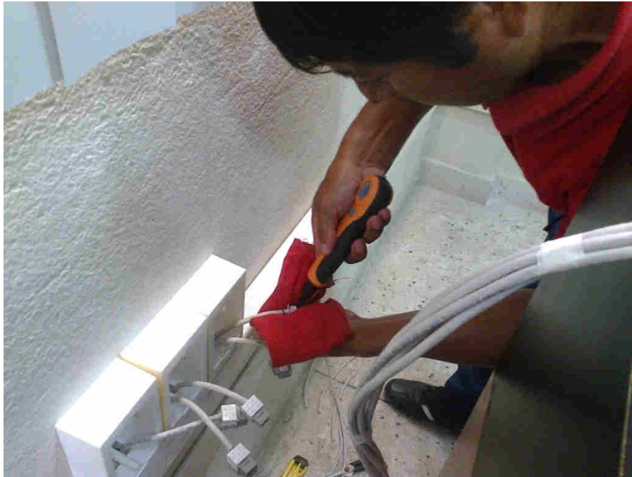
FOTOGRAFÍA 11 INSTALACIÓN DE LOS PUNTOS DE RED
