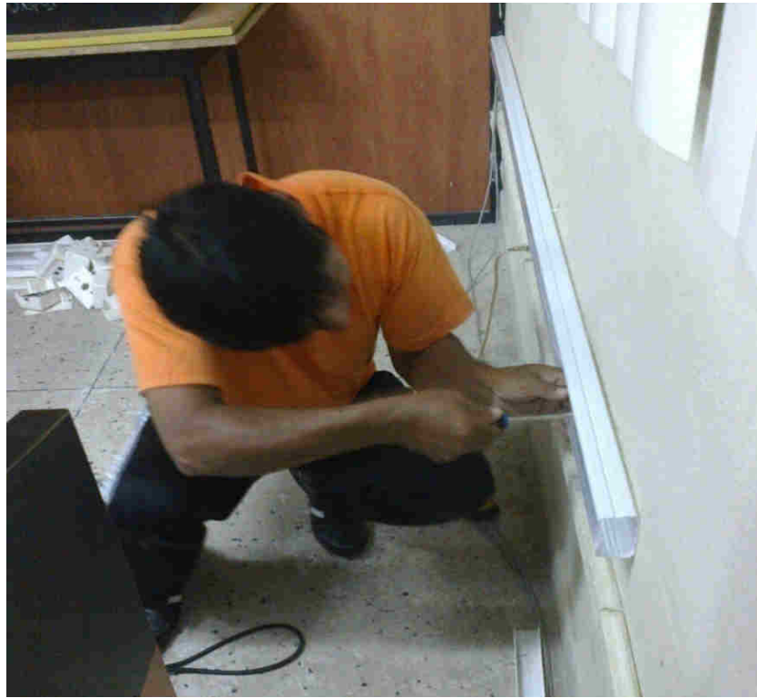
FOTOGRAFÍA 9 INSTALACIÓN DE NUEVAS CANALETAS
