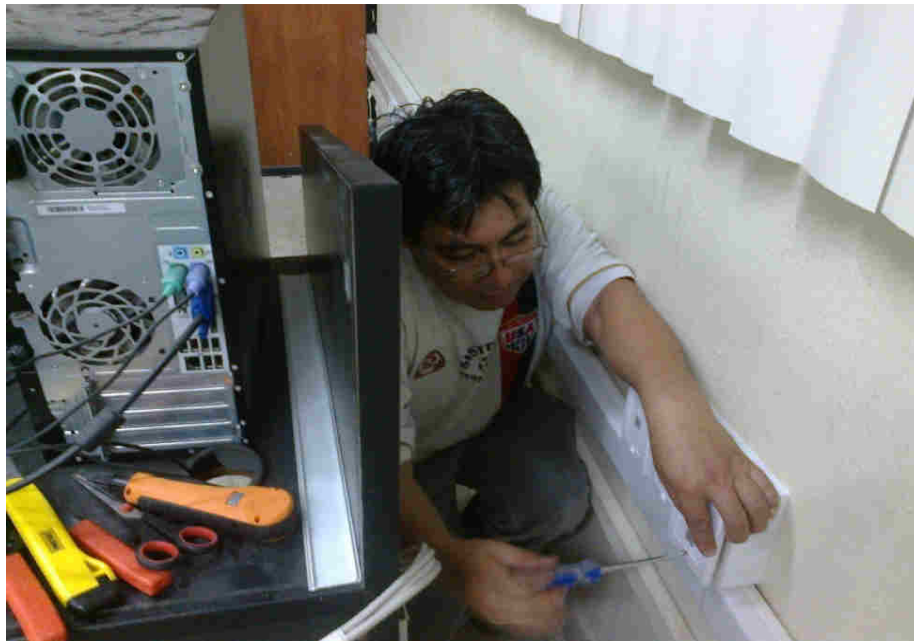
FOTOGRAFÍA 11 INSTALACIÓN DE LOS PUNTOS DE RED
