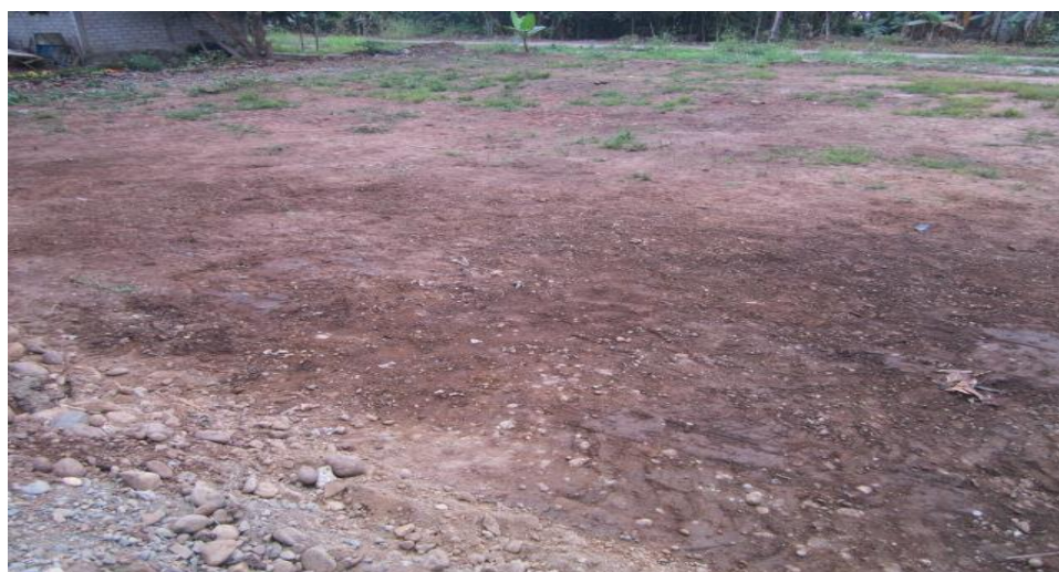
FOTO 2. PREPARACION DEL SUELO.
