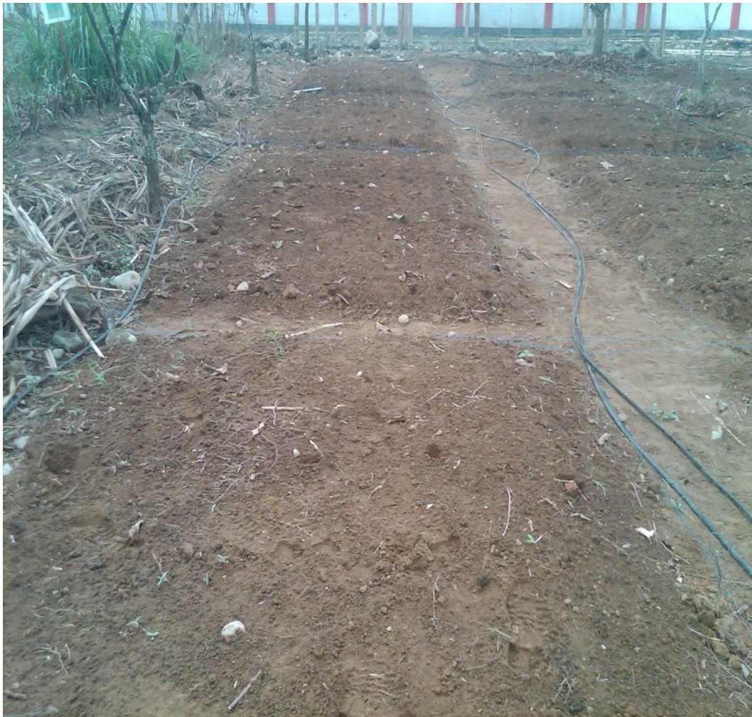
FOTO 1. LIMPIEZA DEL TERRENO
