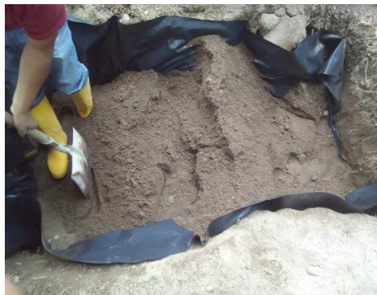
Fotografía 11. . Implementación del prototipo de Biofiltro, impermeabilización del lecho
