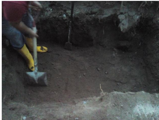
Fotografía 10. Implementación del prototipo de Biofiltro, excavación de la profundidad adecuada para el biofiltro.
