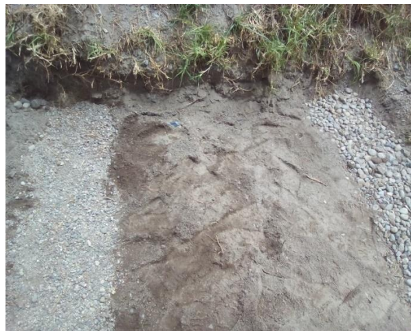
Fotografía 13. Implementación del prototipo de Biofiltro, colocación de la grava y arena por secciones.
