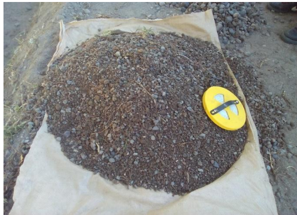
Fotografía 13. Implementación del prototipo de Biofiltro, colocación de la grava y arena por secciones.
