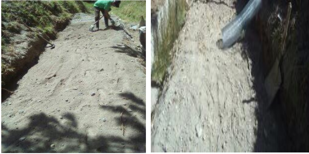
Fotografía 9. Implementación del prototipo de Biofiltro, Nivelación de suelo
