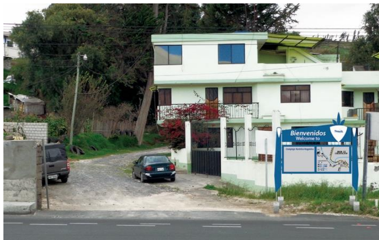
Fotografía 13: Verificación en la Entrada
