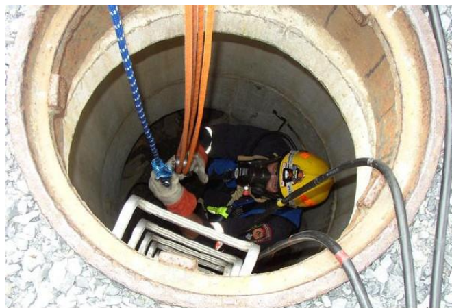
Figura 2. Espacio confinado de alcantarillado.
