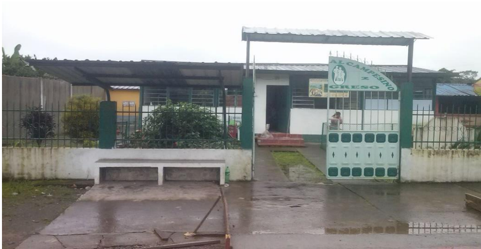
Vista frontal del dispensario médico ubicado en El recinto El Progreso.
