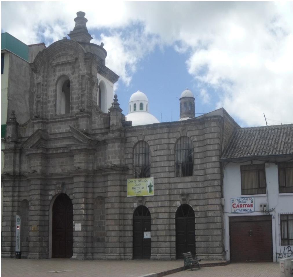
Fotografía N° 5. Iglesia de San Francisco
