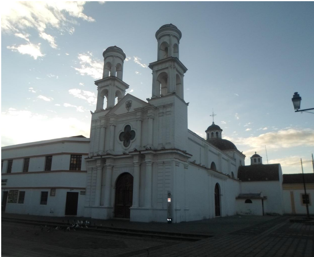
Fotografía N° 3. Iglesia de Santo Domingo y su Plaza
