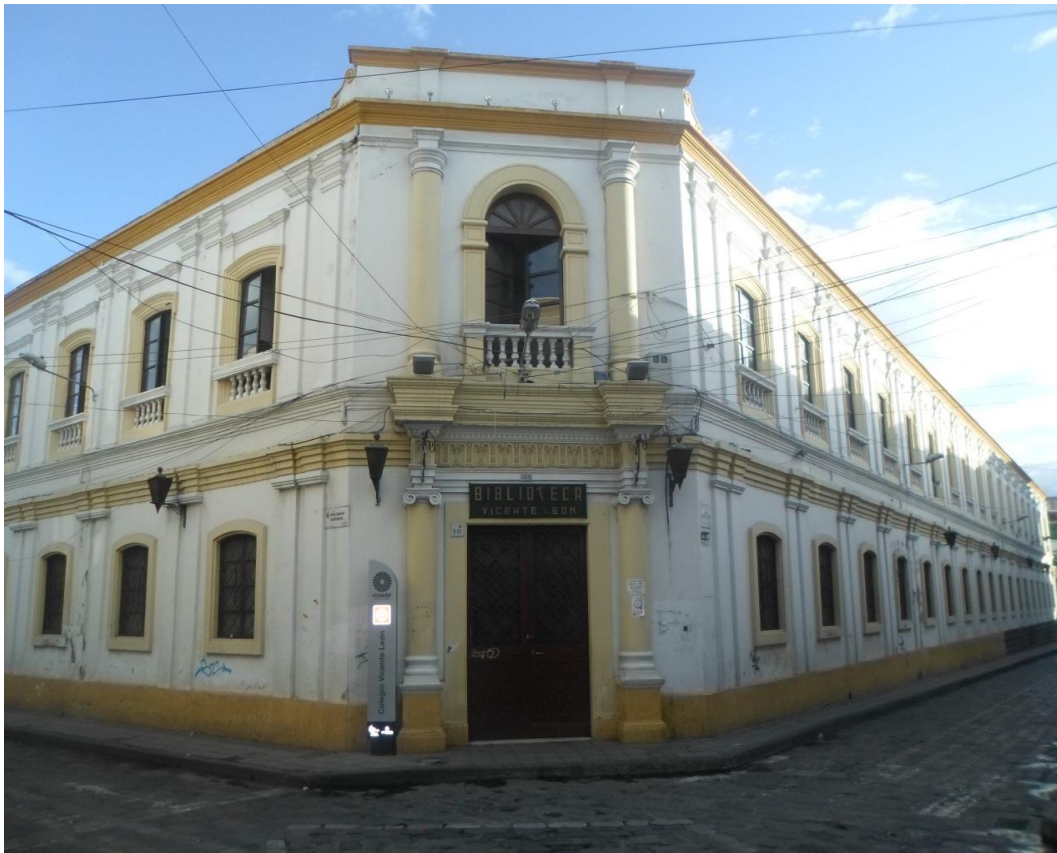
Fotografía N° 9. Colegio Vicente León
