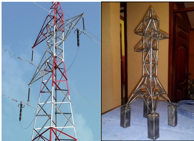
Figura 11. (A) Torre eléctrica– (B) Prototipo torre eléctrica.
