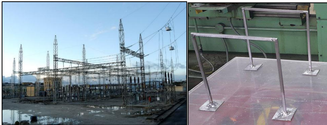
Figura 13. (A) Barras de una subestación eléctrica – (B) Prototipo barras Subestación eléctrica.
