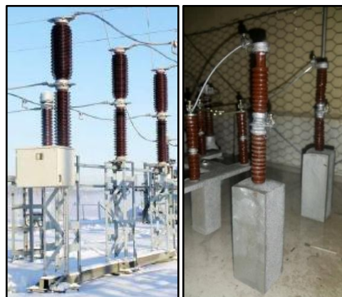
Figura 19. (a) Interruptor LTB E1 – (B) Prototipo interruptores.
