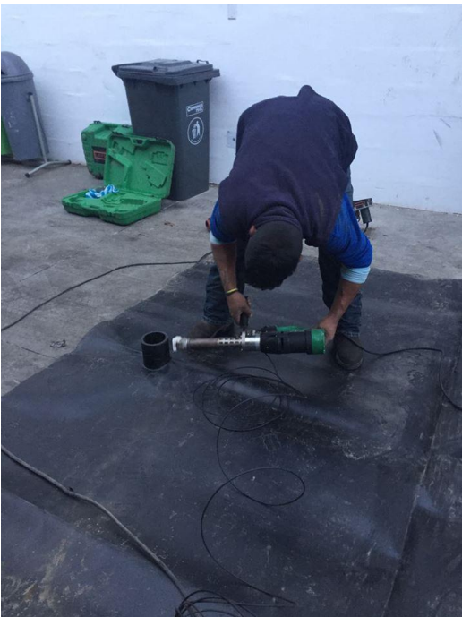
Fotografía 9. Instalación de los acoples para la tubería
