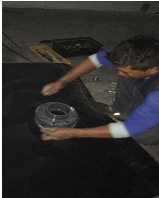
Fotografía 9. Instalación de los acoples para la tubería
