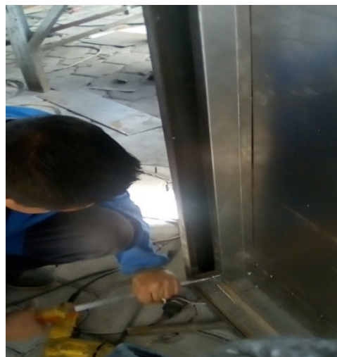
Figura N°21: Colocación de las paredes de la cámara intermedia
