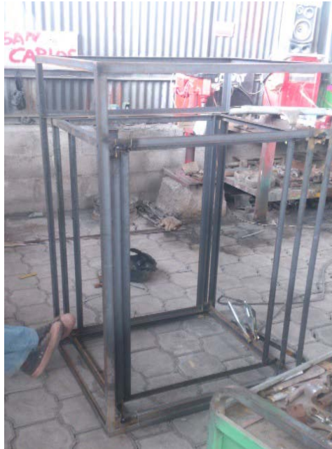
Figura N°19: Estructura terminada del secador
