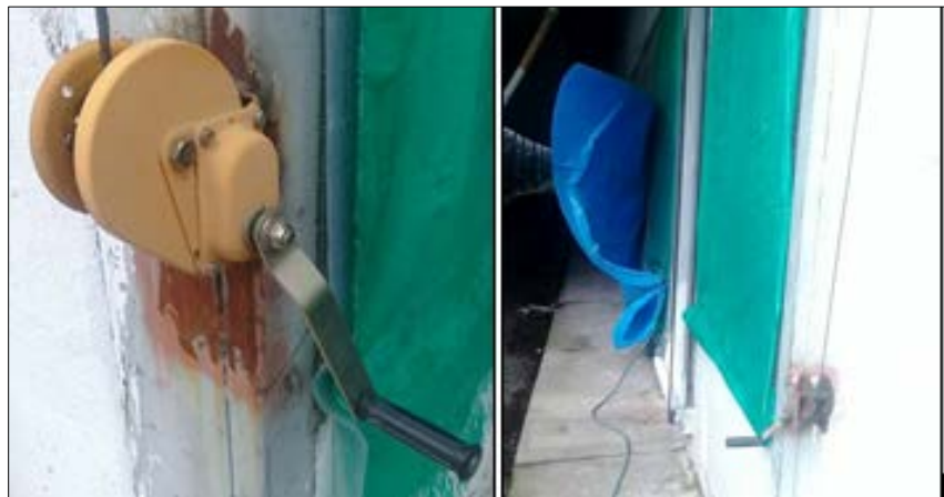
Figura N° 7 Malacate y cortinas del Galpón San Francisco
