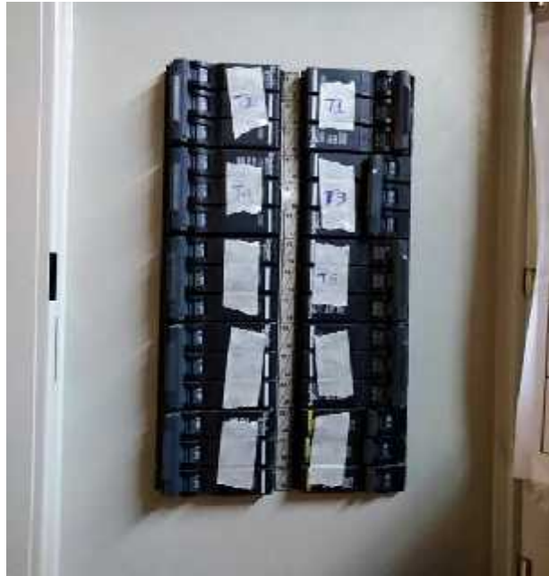
Fotografía 5: Adecuacion y armado de nuevos centros de carga
