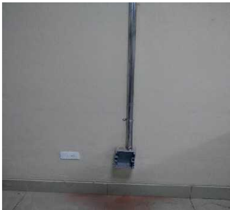
Fotografía 4: Instalación de tubería para nuevos puntos de alimentación
