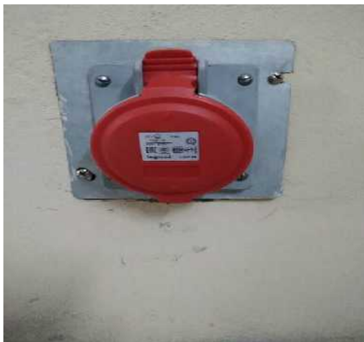
Fotografía 3: Instalación de nuevo punto de alimentación trifásicos
