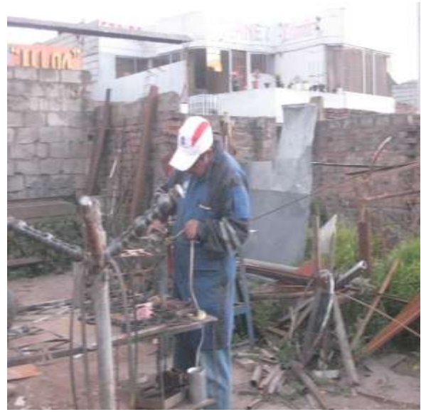
Pulido de escorias de soldadura
