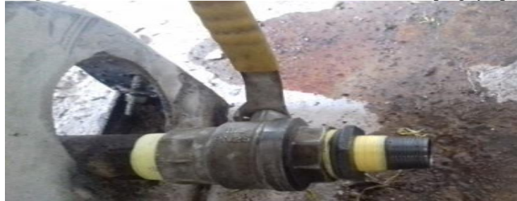
Figura 21. Válvula de bola o válvula de esfera de 1 ½ pulg. y 1 pulg.
