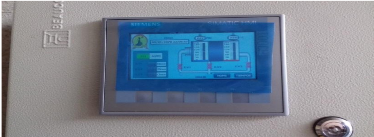
Figura VII. 11. Diseño del HMI KTP400 para verificación de temperaturas y aplicación las purgas en función manual y automática
