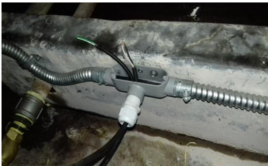
Figura IV. 5. Instalación del cableado para el control de las electroválvulas.
