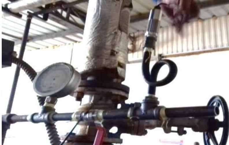
Figura IV. 6. Implementación termocupla y sensor de temperatura.
