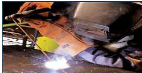
Figura 8. Soldadura en aceros inoxidables
