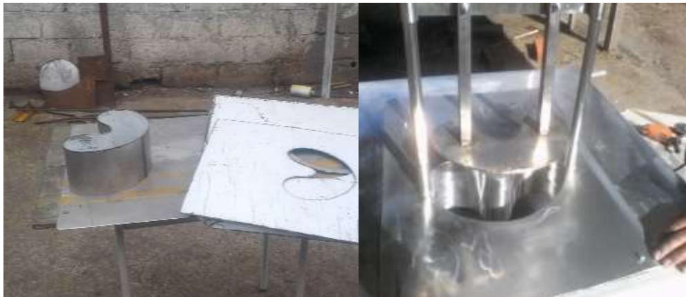
Construcción de la camara de alimentación
