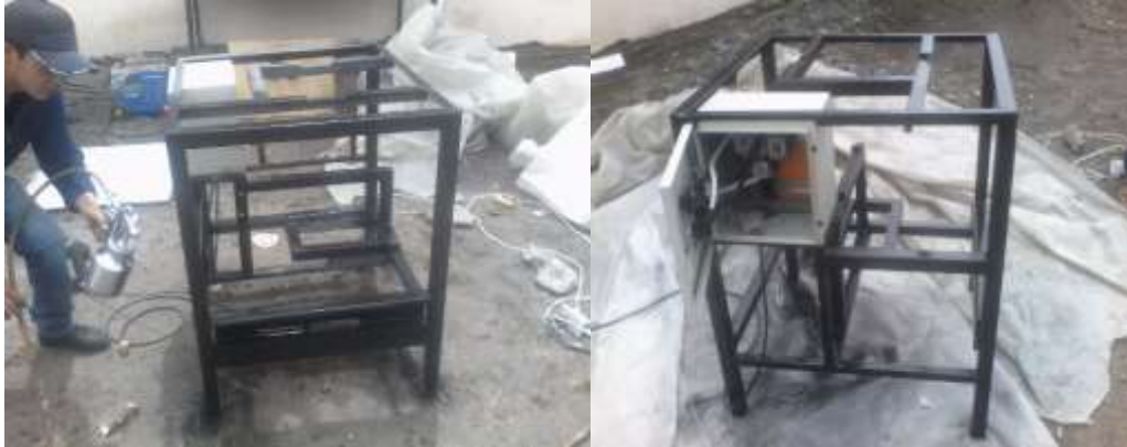
Pintado de la estructura de la máquina
