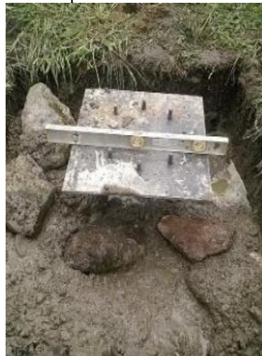
Figura 4.17.1. Fijación del Cimiento para la estructura.
