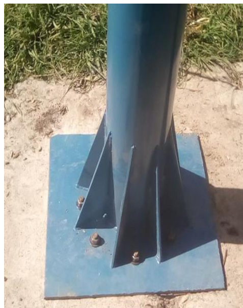
Figura 4.17.2. Base de soporte de la torre.
