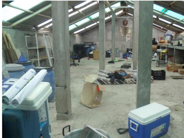
Los cerramientos exteriores comprenden paredes de mampostería y no existen alfeizares para ventanas. La cubierta está constituida por techo de ardex gris y translucido con estructura de vigas metálicas y de madera.
