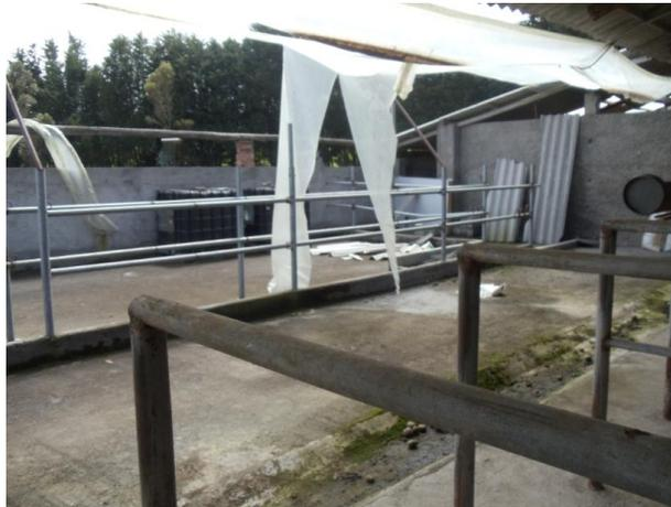
La subestructura está conformada por un muro de contención, un piso de piedra y concreto, columnas de hormigón armado y soportes metálicos
