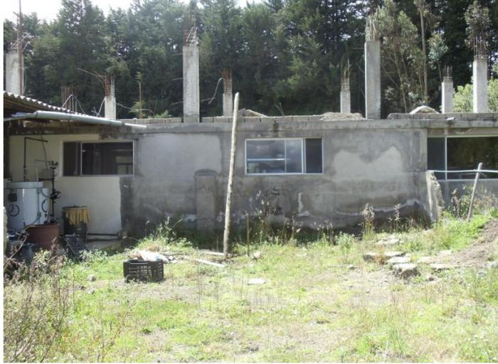
La subestructura está conformada por un piso de piedra y concreto. La superestructura está constituida por columnas de hormigón armado y losa fundida
