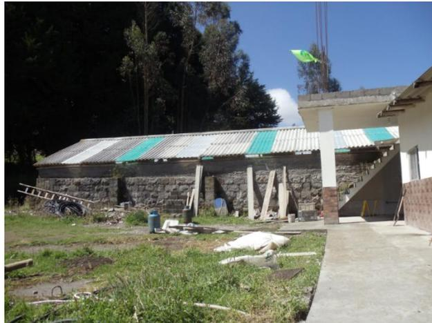
La subestructura está conformada por muros y piso de piedra y concreto. La superestructura está constituida por columnas de hormigón armado
