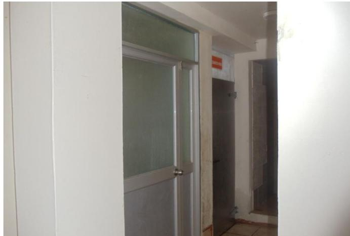
Para los cerramientos interiores y exteriores comprende paredes de mampostería. En esta área no se han colocado cubiertas pues se pretende en el futuro construir una planta más.
