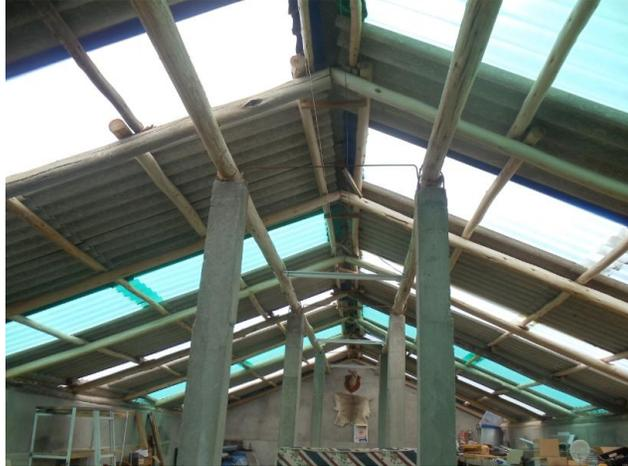
Se ha realizado la instalación provisional de la red eléctrica para luminarias sobre la estructura cubierta, sin ductos ni protecciones
