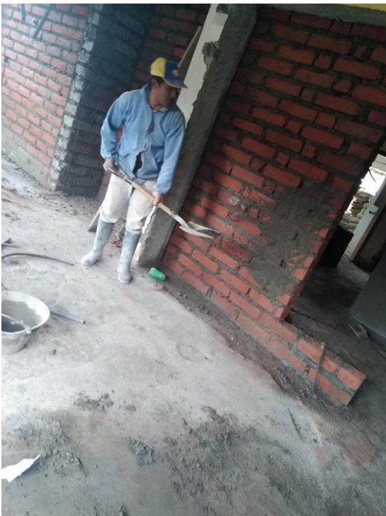
Foto 24. Maestro albañil enluciendo paredes
