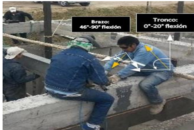
Foto 1. Obreros nivelando vigas
