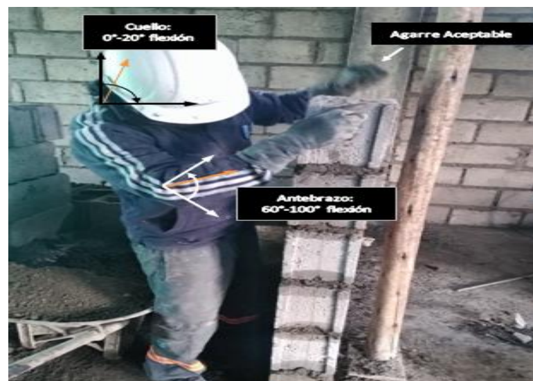
Foto 7. Maestro albañil realizando levantamiento de pared nivel medio.
