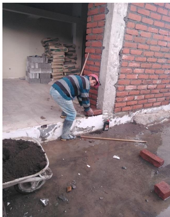
Foto 29. Pegando mampostería nivel bajo
