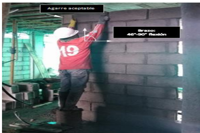
Foto 6. Maestro albañil realizando levantamiento de pared nivel alto.
