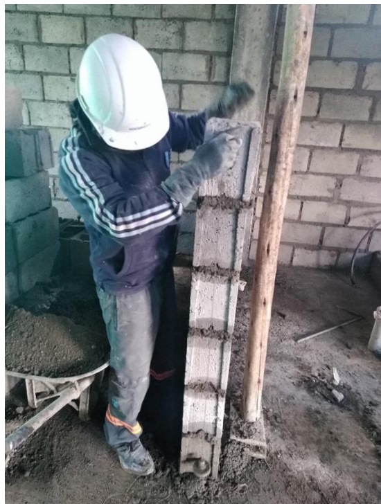
Foto 25. Maestro albañil pegando mampostería nivel medio.
