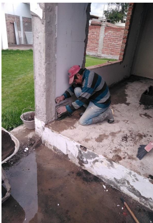
Foto 27. Pegando mampostería nivel bajo
