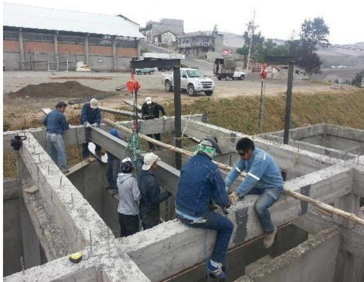
Foto 12. Nivelación de vigas en el montaje de estructuras
