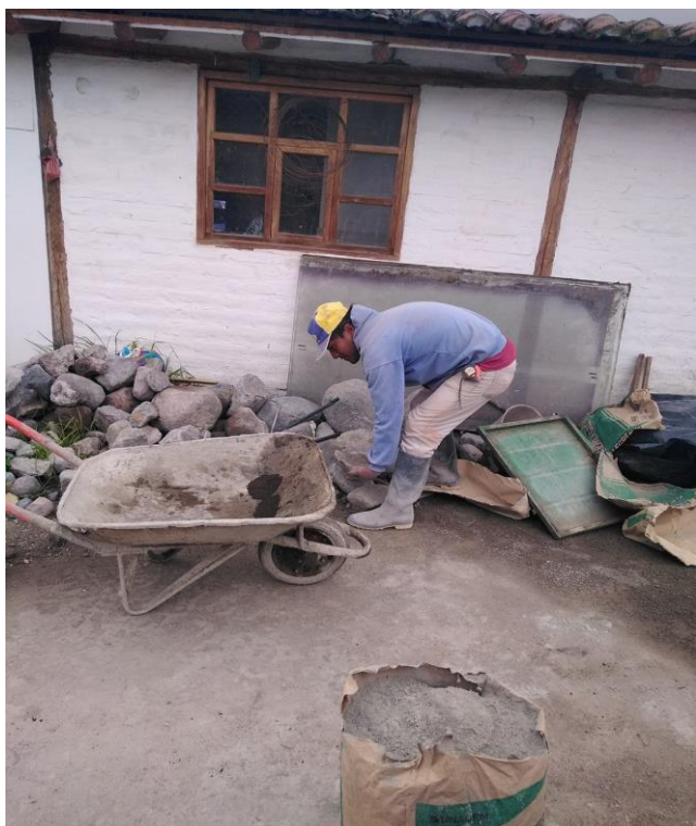
Foto 26. Ayudante de albañil realizando empedrado del piso
