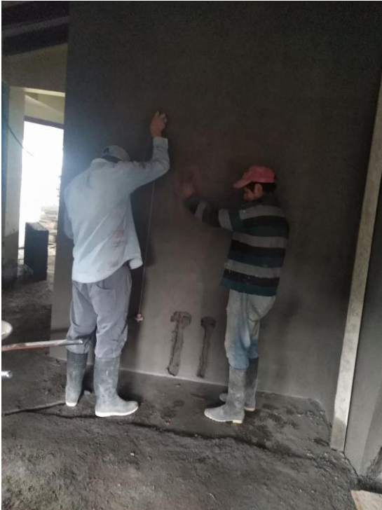
Foto 22. Maestro albañil enluciendo paredes
