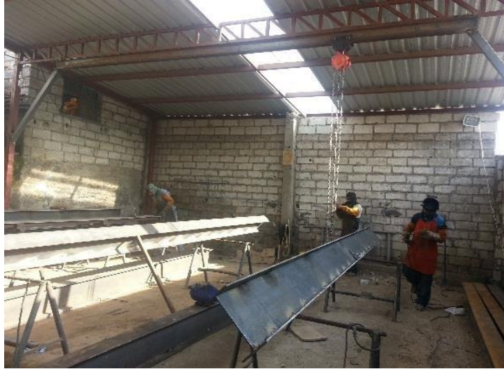
Foto 11. Trabajo de preparación de vigas y soldadura en el taller
