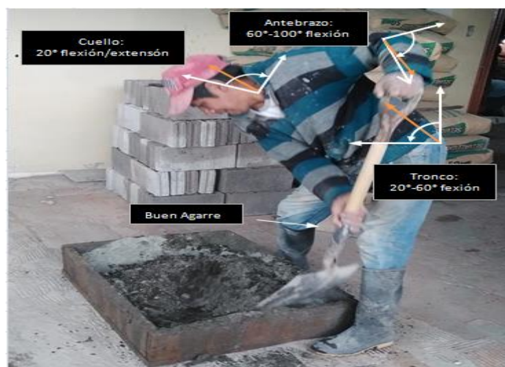
Foto 9. Ayudante realizando mezcla de concreto.
