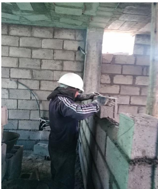
Foto 28. Pegando mampostería nivel medio
