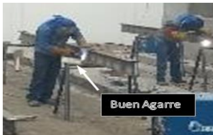
Foto 3. Soldador realizando vigas para montaje.
