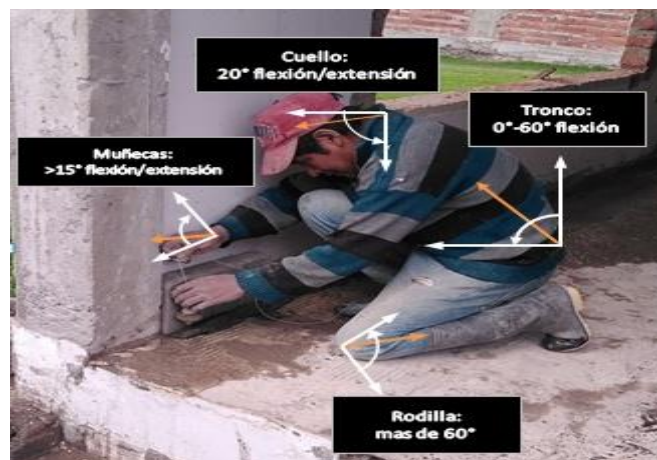
Foto 8. Maestro albañil realizando levantamiento de pared nivel bajo.
