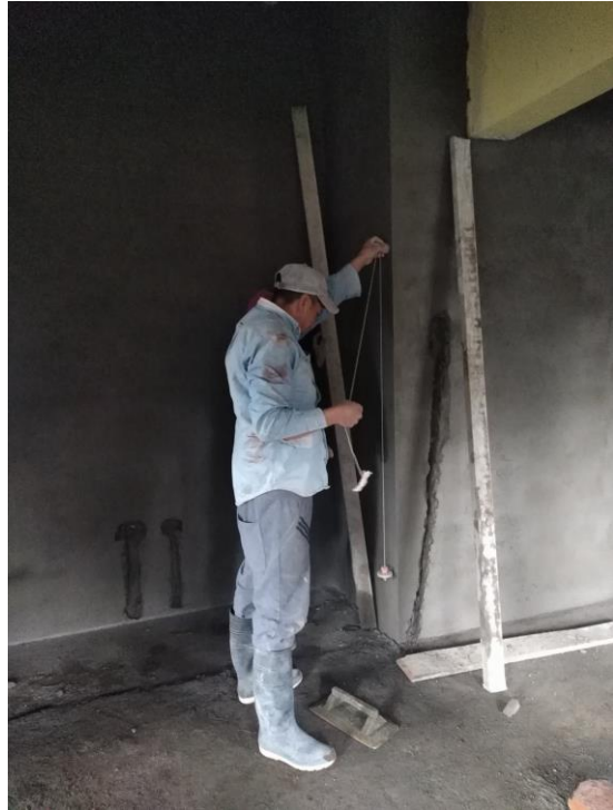
Foto 23. Maestro albañil verificando nivel
