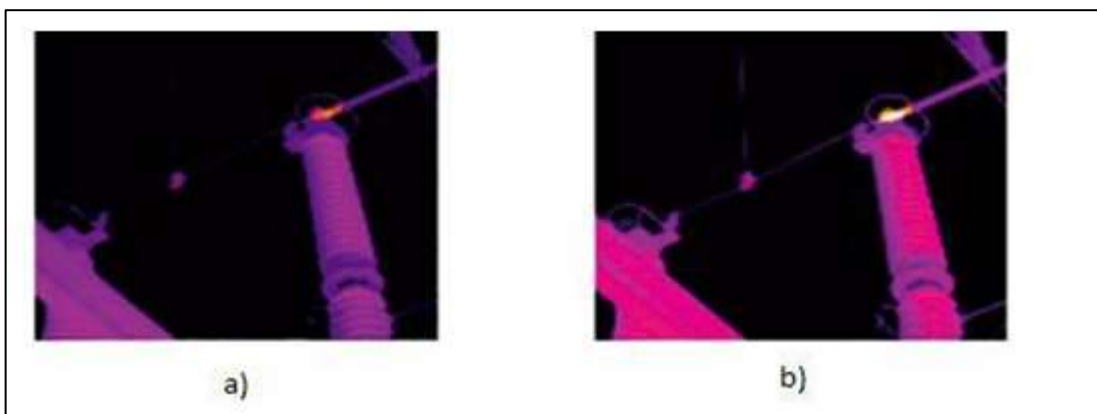
Figura 18. a) Termografía tomada con un viento de 14 Km/h; b) Termografía tomada sin viento
