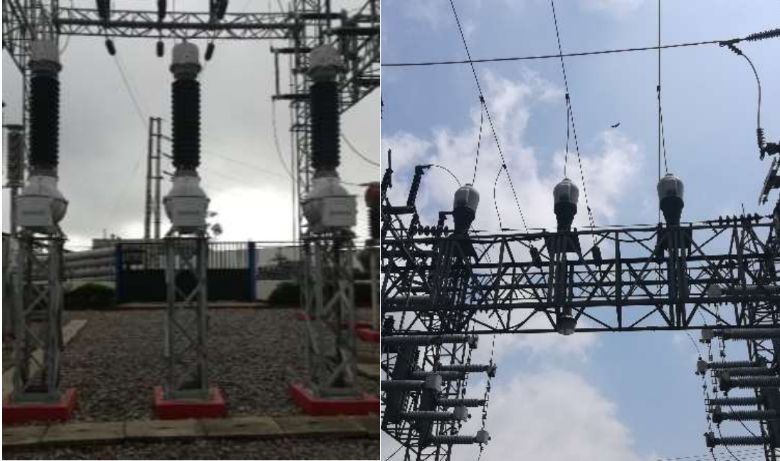
Figura 25. Transformadores de potencial
