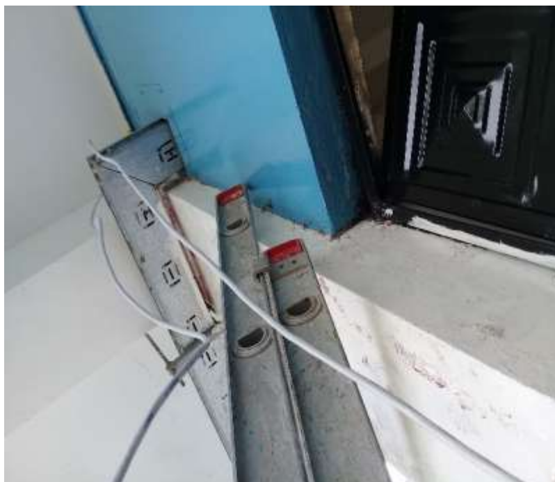
Gráfico 13: Proceso de Cableado estructurado
