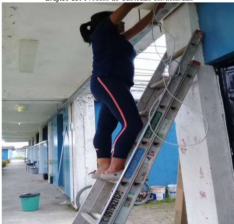
Gráfico 15: Proceso de Cableado estructurado
