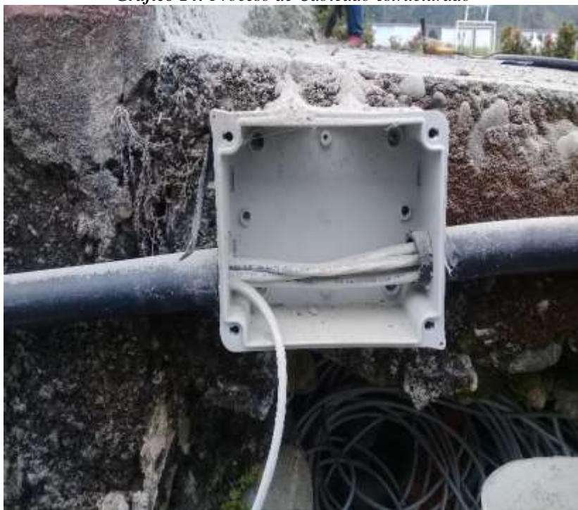
Gráfico 14: Proceso de Cableado estructurado
