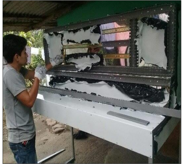
Instalación de canaletas
