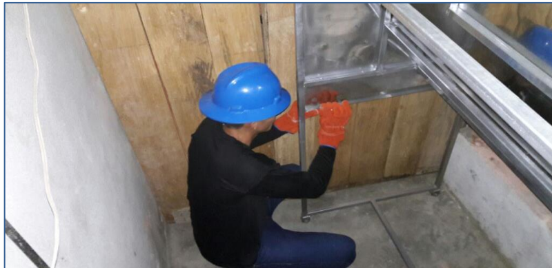
Figura 17. Construcción mesa metálica
