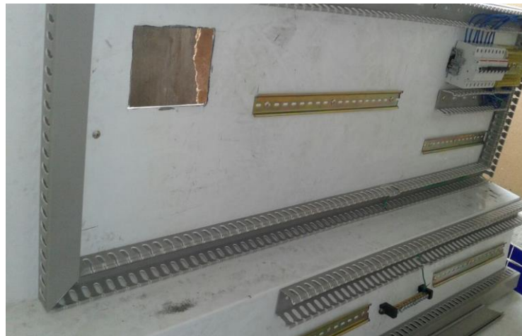
Figura 19. Montar canaletas
