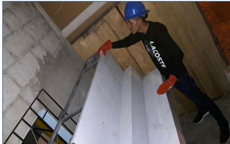
Figura 18. Montar las láminas en las ranuras de los perfiles de aluminio
