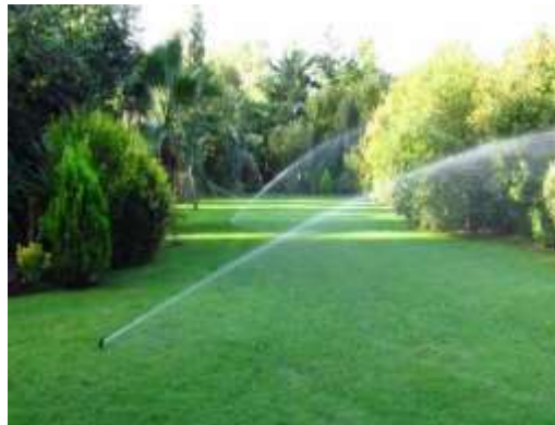
Figura N° 1: Sistema de aspersión
