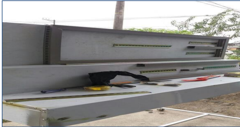
Figura 12. Montar canaletas
