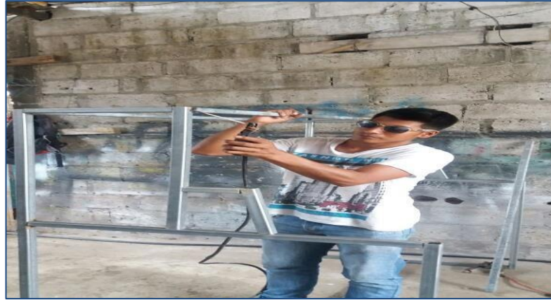
Figura 10. Construcción base metálica
