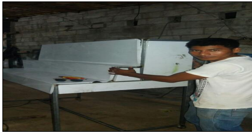
Figura 11. Colocación de láminas de acero en los perfiles de aluminio
