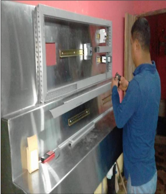
Instalación de los Relé
