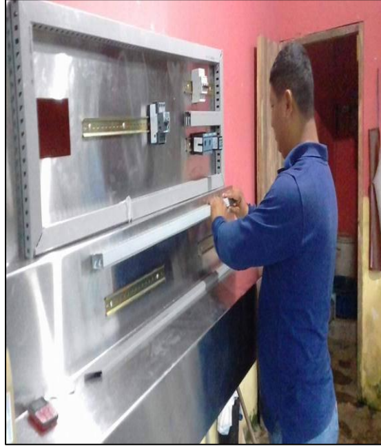
Térmicos Instalación de canaletas
