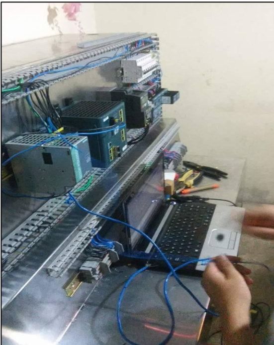
Instalación de software del PLC
