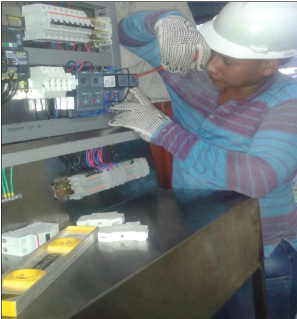
Instalación de contactores auxiliares
