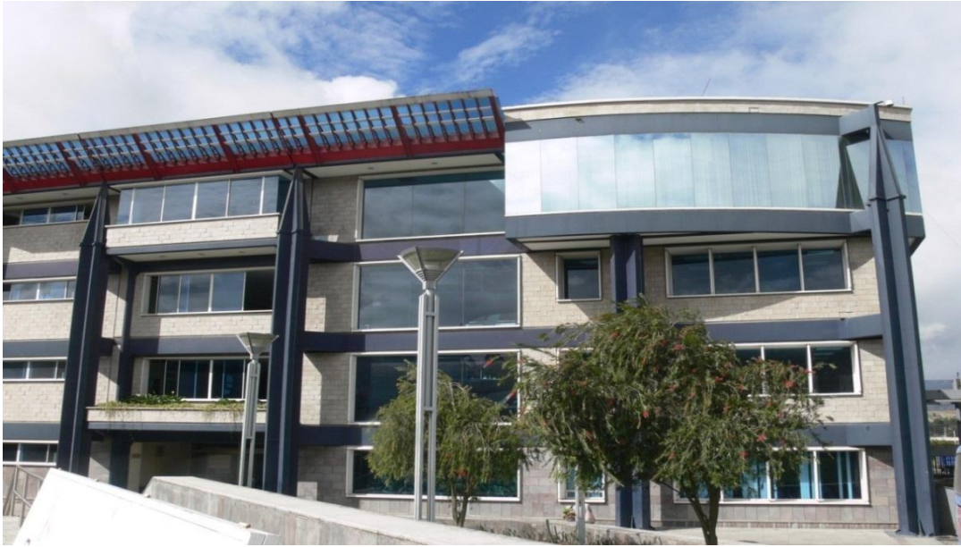
Anexo 7.- Vista de la Parte posterior del Bloque “B” de la Universidad Técnica de Cotopaxi.
