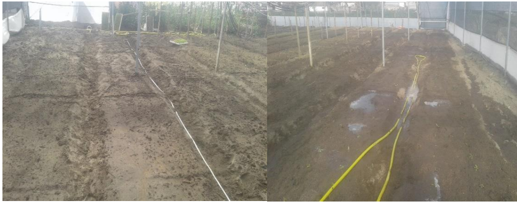
Fotografía 4. Preparación de suelo y elaboración de camas
