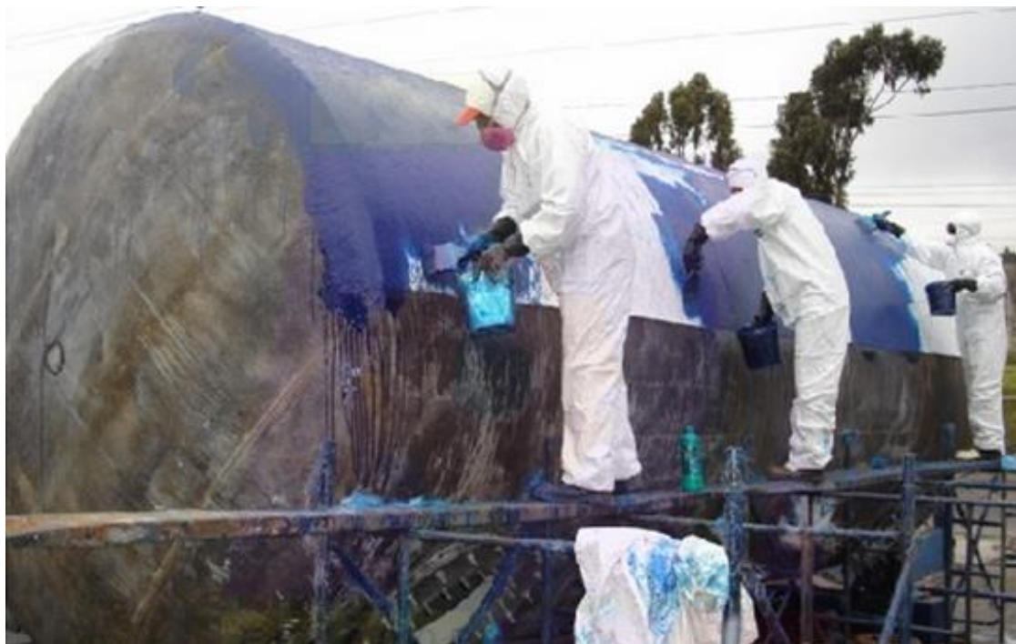
Enfibrado de tanques
