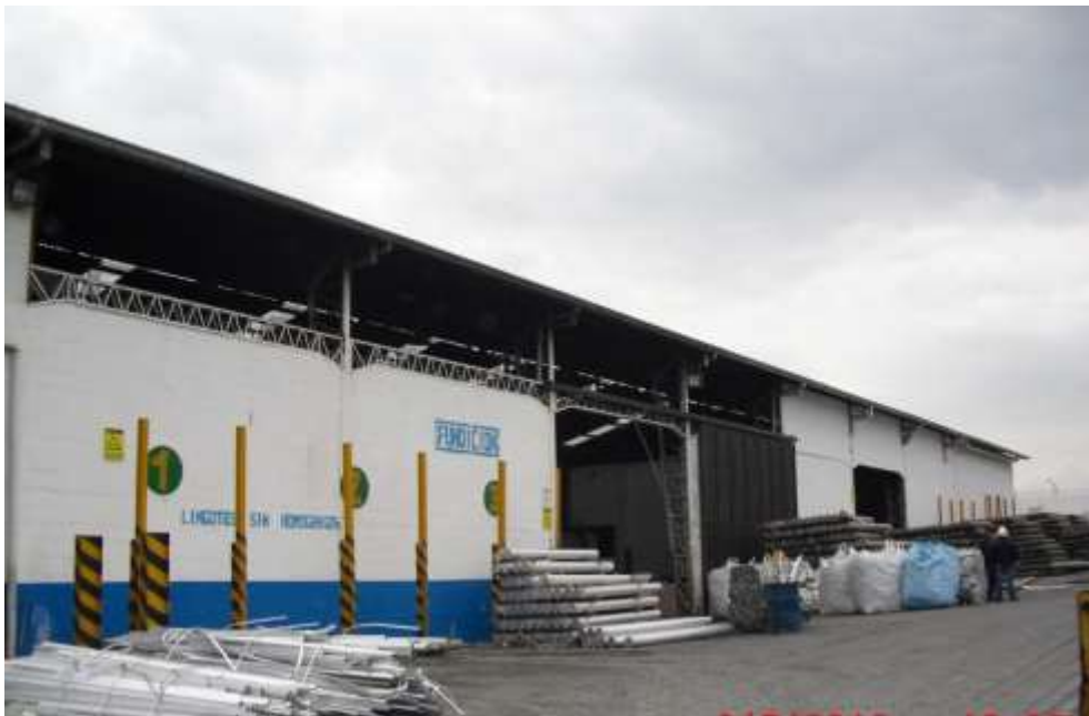
PLANTA DE FUNDICION CEDAL SA.
