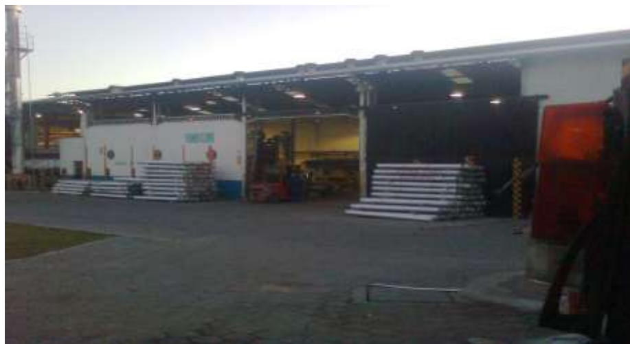
Figura 3.8.- Planta de fundición CEDAL S.A. ubicada en la ciudad de Latacunga.
