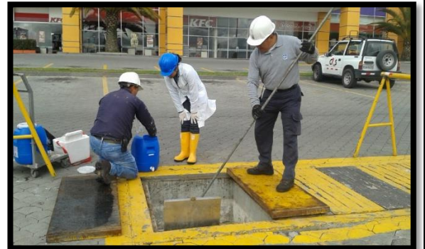
ANEXO FOTOGRAFICO 11: Colocación de la dosis óptima en la planta de tratamiento.
