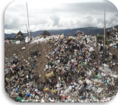
Fotografía 2: Infraestructura para la captura de gases.
