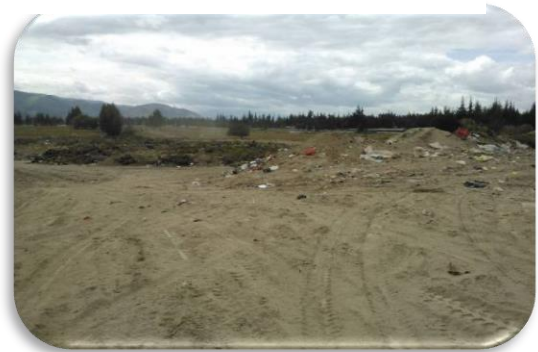
Fotografía N° 6 Lugar de trabajo relleno
