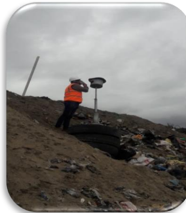
Fotografía 5: Control de Chimenea.
