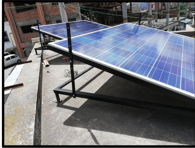
Figura 9.5. Montaje en su correspondiente estructura de paneles fotovoltaicos.
