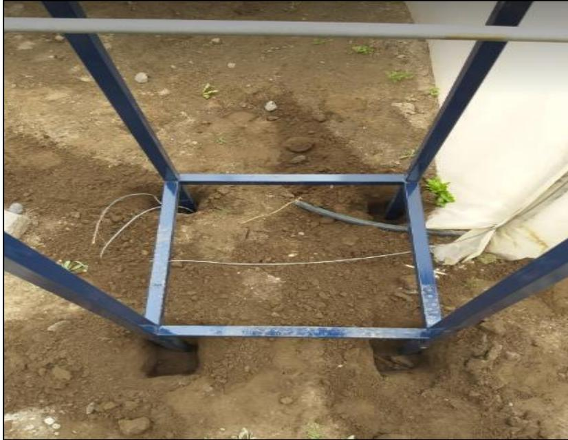
**Figura I.1.** Excavación para estructuras
