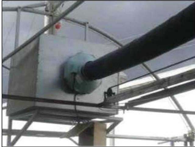
**Figura. 3. 2** Sistema de distribución de calor
