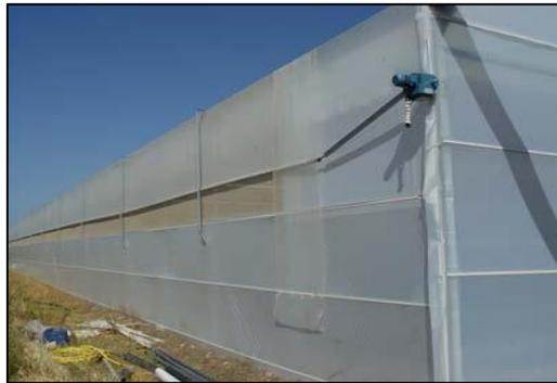
**Figura. 3. 6** Ventilación lateral
