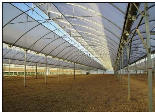
**Figura. 3. 5** Invernadero Multi-túnel con ventilación cenital
