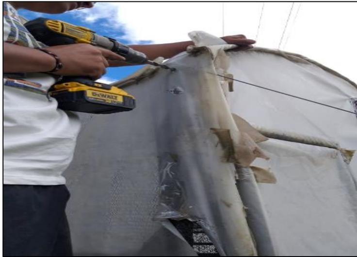
**Figura 5. 18** Perforación de la estructura metálica del invernadero
