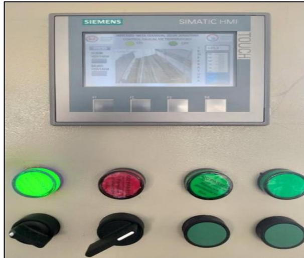
**Figura 5. 25** Sistema de control de temperatura
