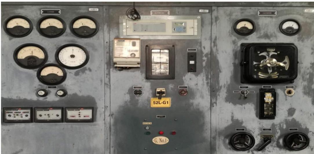
**Figura 3.3:** Tablero de control para cada grupo generador de la Central Illuchi I
