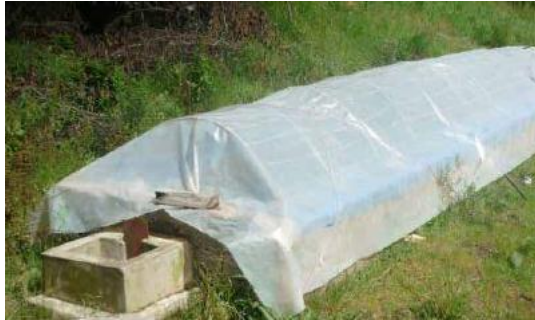
Figura 3.15. Invernadero para protección de biodigestor. Fuente: [33].
