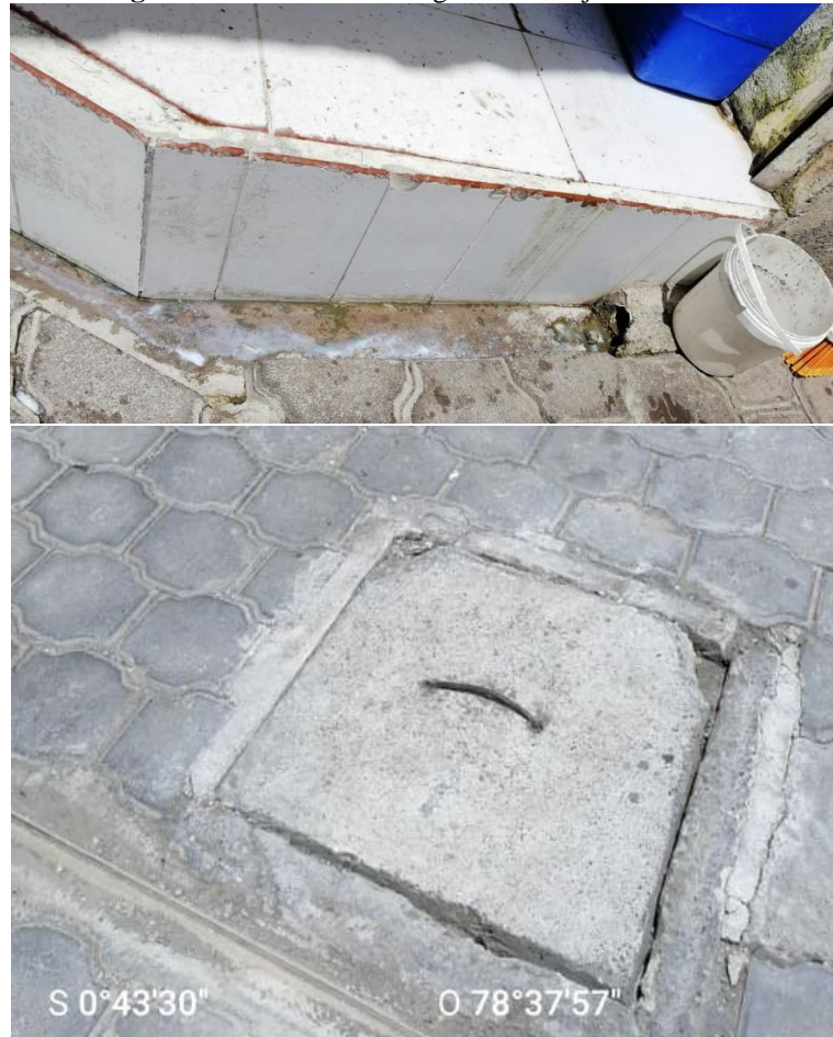
Figura 14. Efluentes descargados a la caja de revisión.
