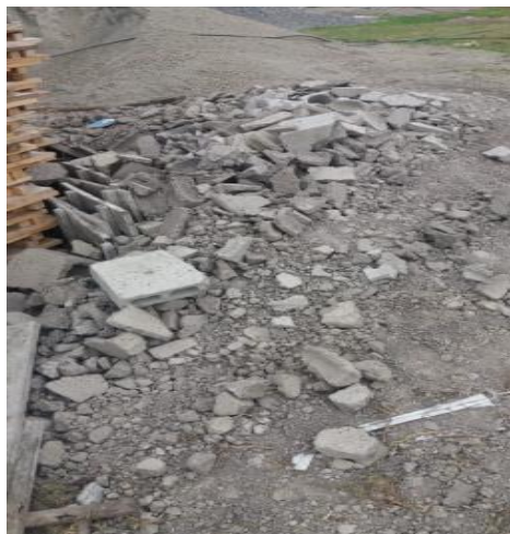
Gráfico 1. Bloques en mal estado
