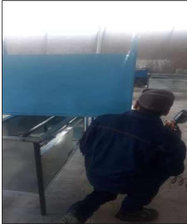
Recubrimiento de pintura liquida en el modular
