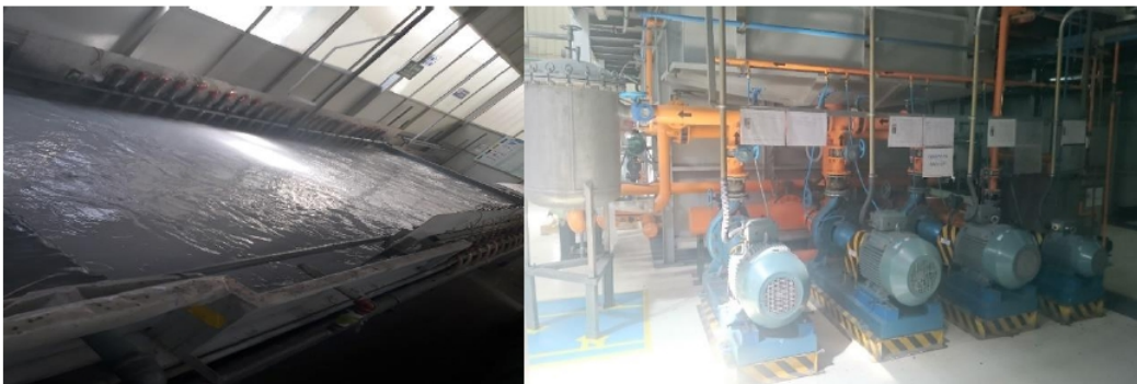
Gráfico 44. Cuba ECOAT y bomba A, B, C, D.
