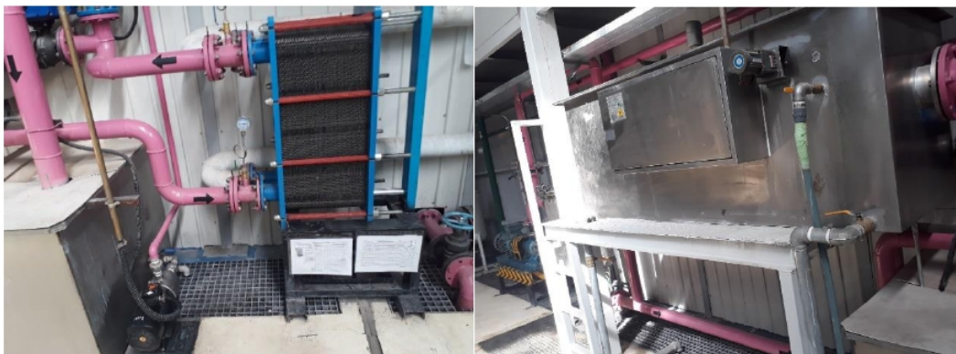
Gráfico 36. Intercambiador de calor, sistema de desengrase
