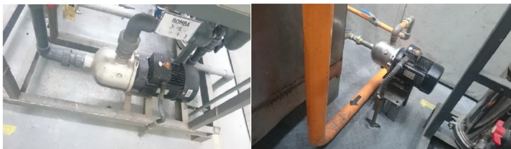
Gráfico 47. Bomba de Ultra filtrado.
